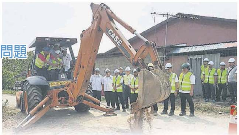
■阿占米（中）在众人陪同下，为更换水管工程主持动土礼。
