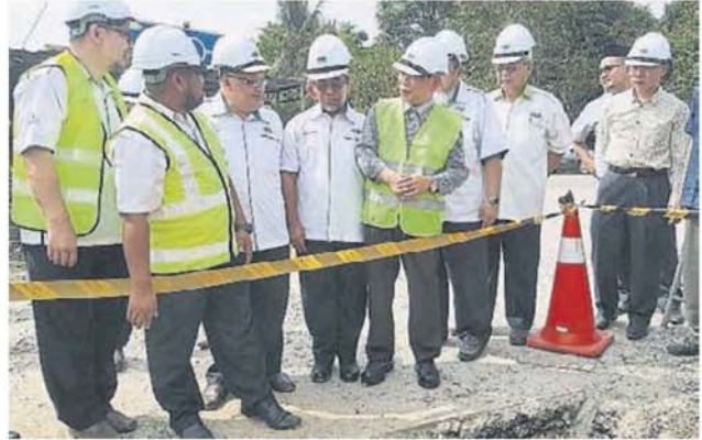
■阿占米（右4）向水供公司了解，更换水管工程事宜。
